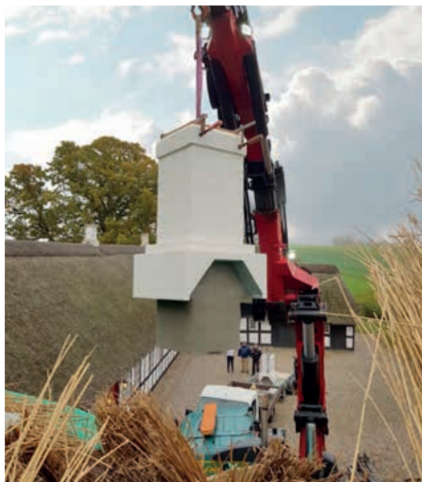
Foto 58 Opsætning af ny skorsten med udkragning
