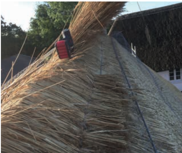
Foto 32 Rygning med overbuk
