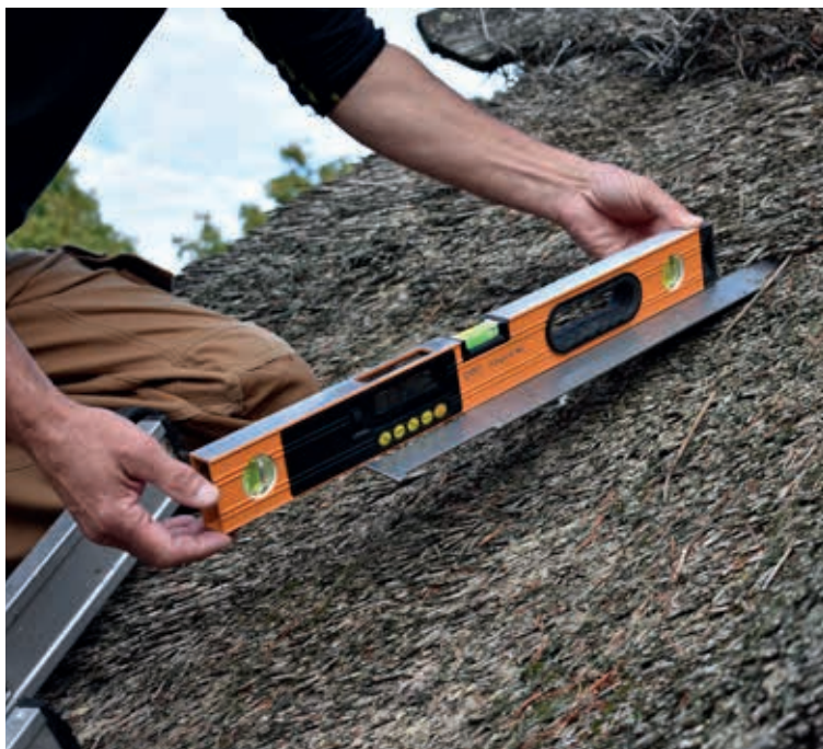
Foto 9 Måling af rørenes hældning
