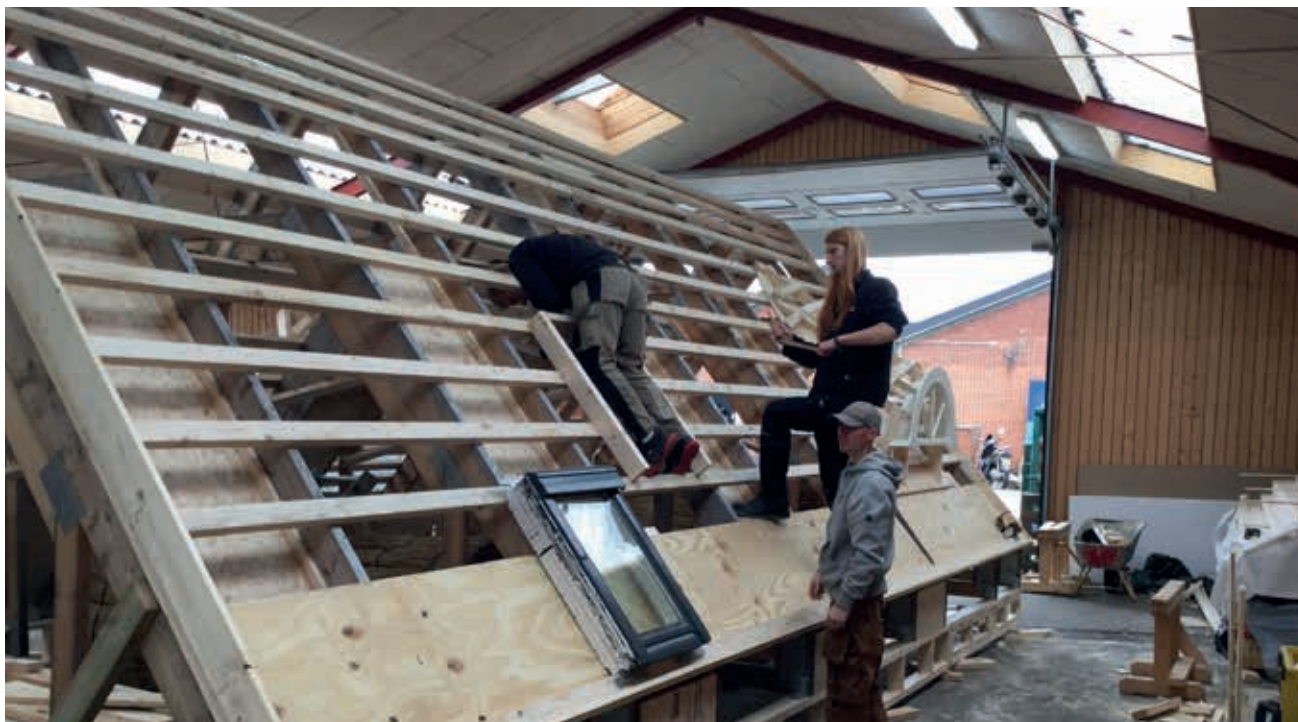
Foto 46 Tagkonstruktion lægtet til stråtag
