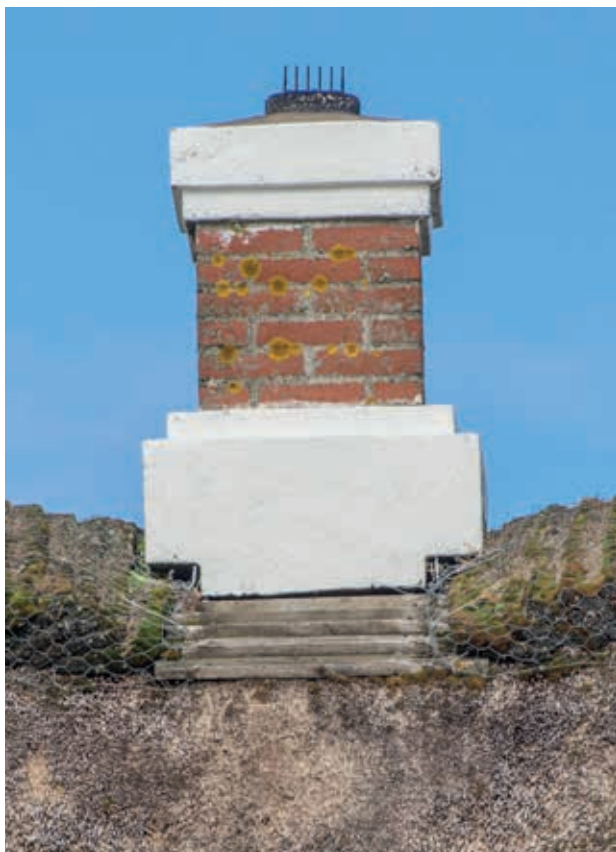
Foto 56 Skorsten med muret udkragning
