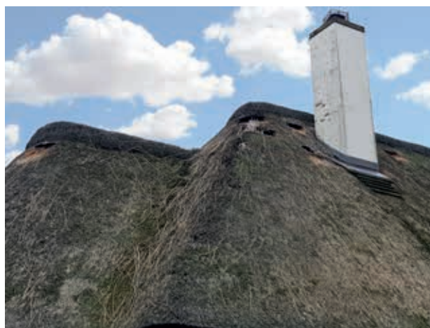
Foto 65 "Fugleskader"
