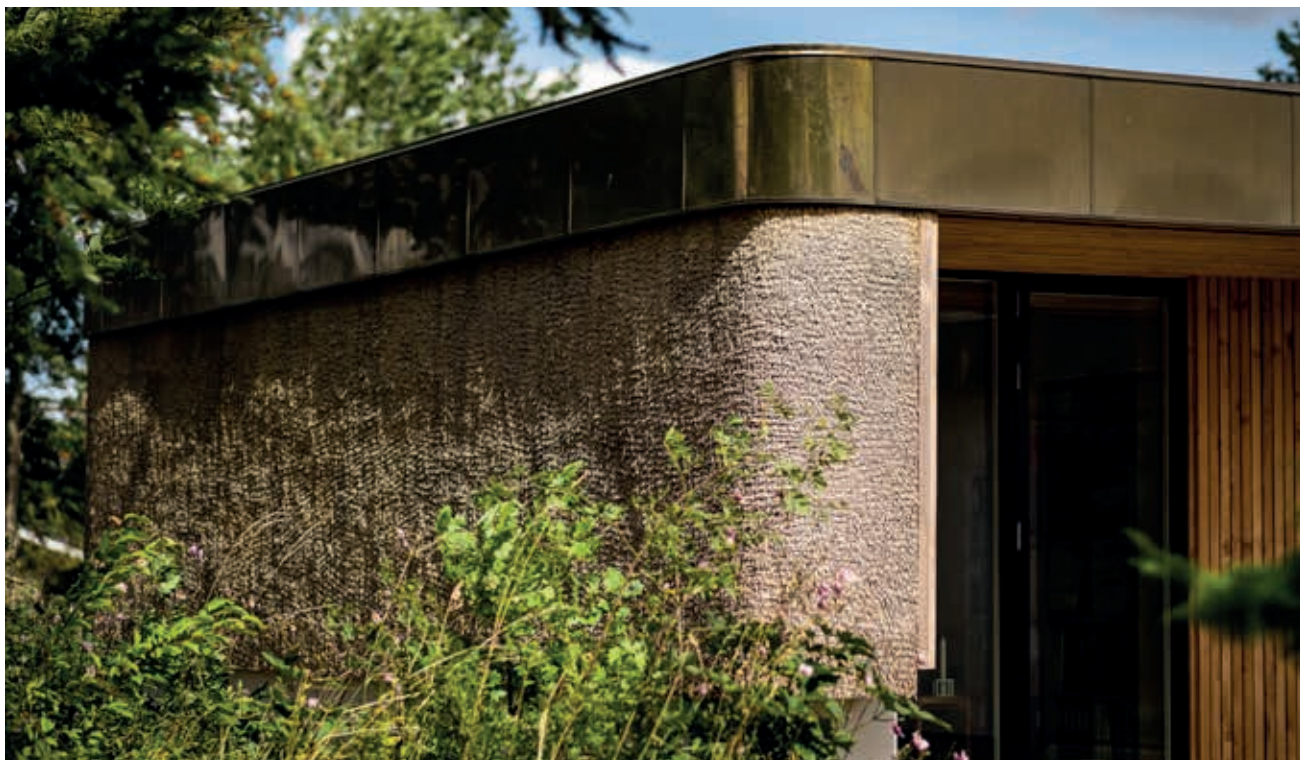
Foto 70 Tækning af lodret facade
