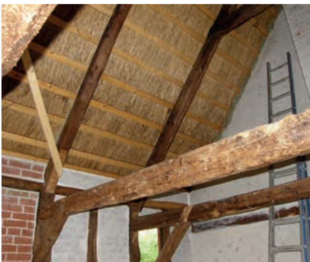
Foto 30 Brolag sikrer en pæn underside
