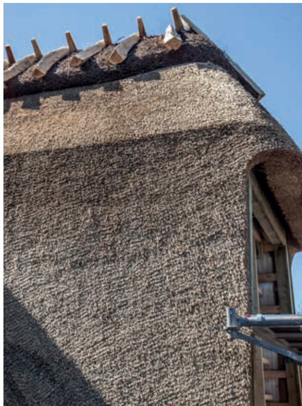
Foto 73 Tækning af mansardtag
