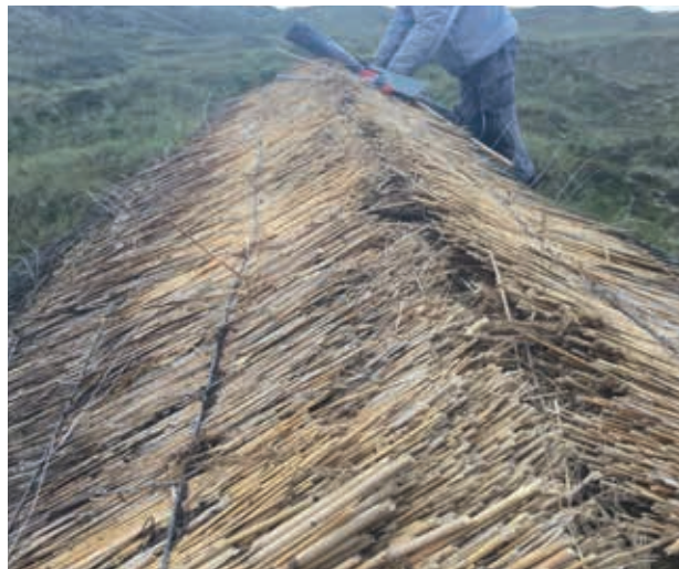
Foto 33 Rygning, der er klippet
