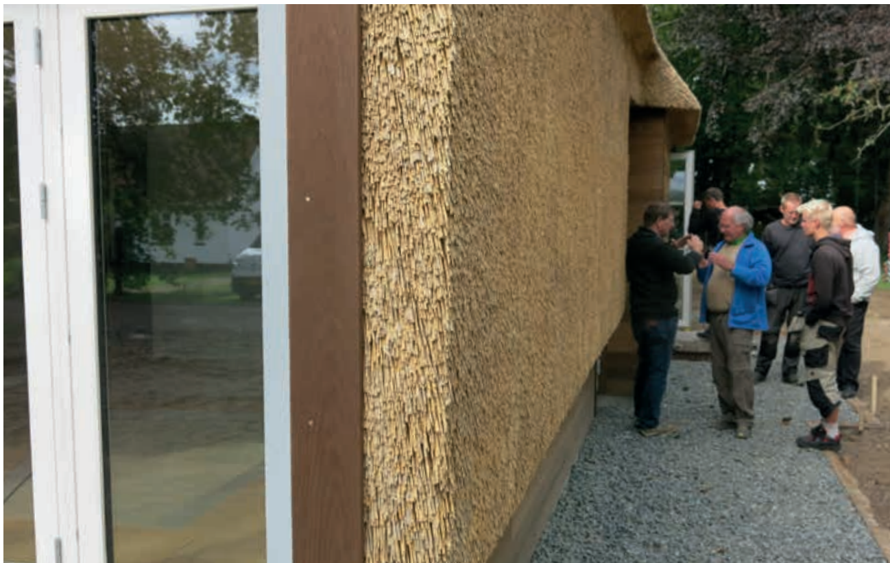
Foto 71 Lodret tækning – Det Åndbare Hus
