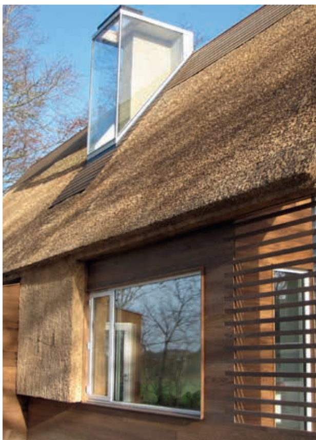
Foto 72 Lodret tækning – Det Åndbare Hus
