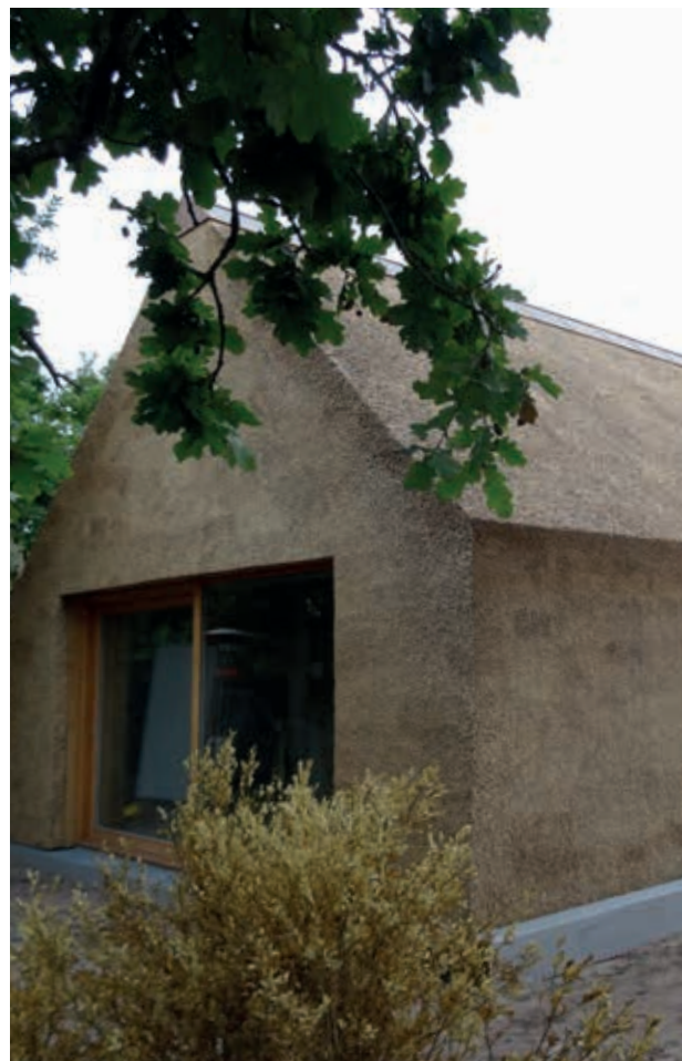
Foto 2 Tag og facade tækket ud i et
