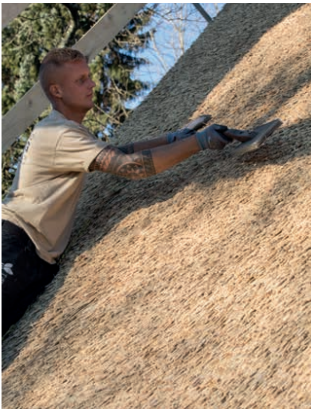
Foto 34 Tagfladen bankes på plads med en tækkeskovl
