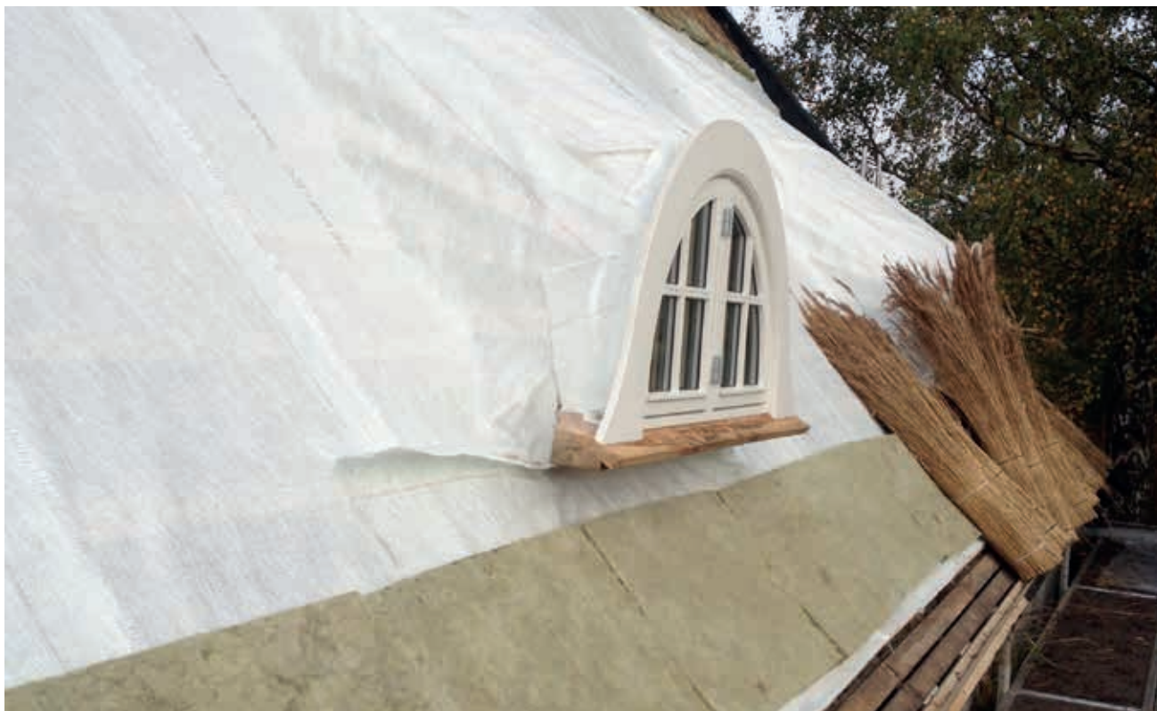
Foto 6 Brandsikring med godkendt glasfiberdug og kantisolering
