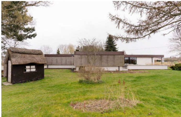
Der er udgang til haven fra stort set alle rum i det 179 kvadratmeter store hus. I den ene ende af haven står et legehus – naturligvis stråttækt. Fotos: Sarah Marie Winther
